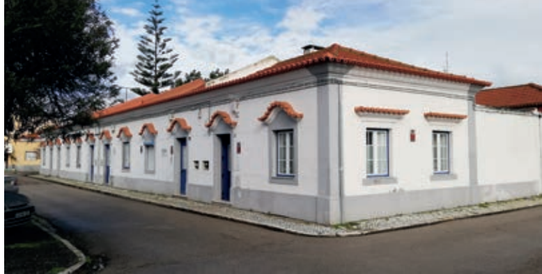
➤ Sede da APMI, Bairro Santa Bárbara
